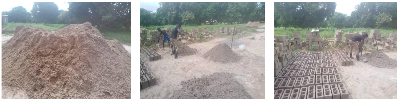
De cementen bakstenen moeten een tijd drogen. Water maakt ze sterker. Bij teveel water vallen ze uiteen. Lastig werken.
