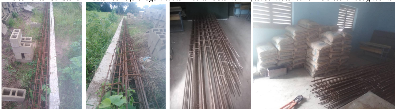
De muren van cementen bakstenen worden om de drie meter voorzien van een betonnen palen. Deze verankeren de muren. Het vlechtwerk voor de palen werd tegelijk met de bakstenen gemaakt en in afwachting van de bouw opgeslagen.
